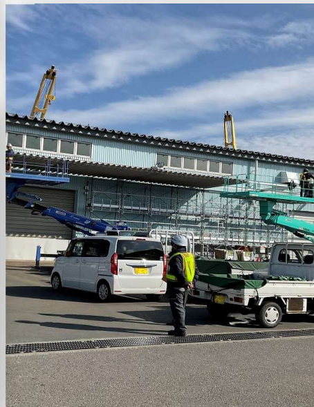
港湾施設改修工事
